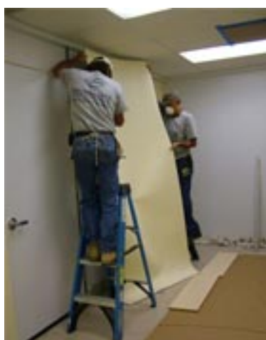
Acoustiblok Wallcover (under montasje og duk)
